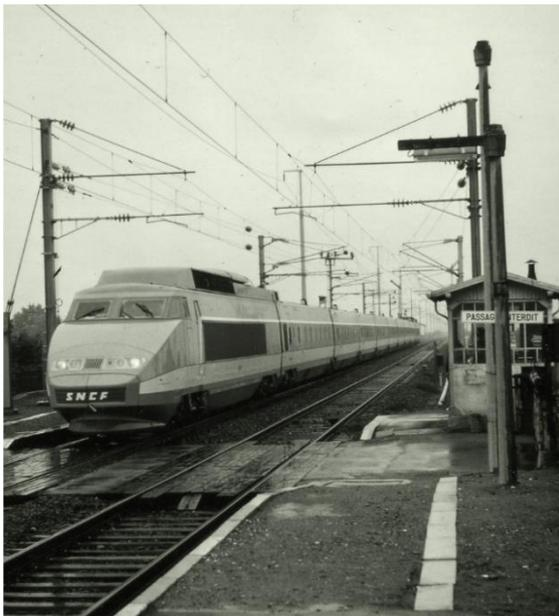
La ligne a connu de grandes modifications par la suppression de tous les passages à niveau et la mise en service des trains à la vitesse de 200 km/h, voire de 220 km/h pour les TGV.
