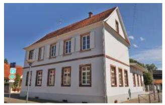
homogène, partie très La ancienne. construite en 1838 en brigues recouvertes de crépi et comportant des encadrements de fenêtres et un bandeau horizontal en représentative style est du « Restauration » des bâtiments publics de cette époque.
