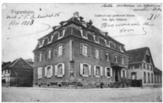
En 1743, la veuve Hansmaennel construit, à l'endroit d'une ancienne auberge, une maison entièrement en pierres avec un colombage de chêne à l'étage recouvert, dès l'origine d'un enduit, le colombage étant réservé aux maisons paysannes.
